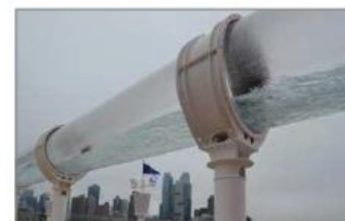
Transperante rør så man kan se vandet, der løber ind i tankene.
