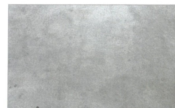
Gulv & loft: Beton
