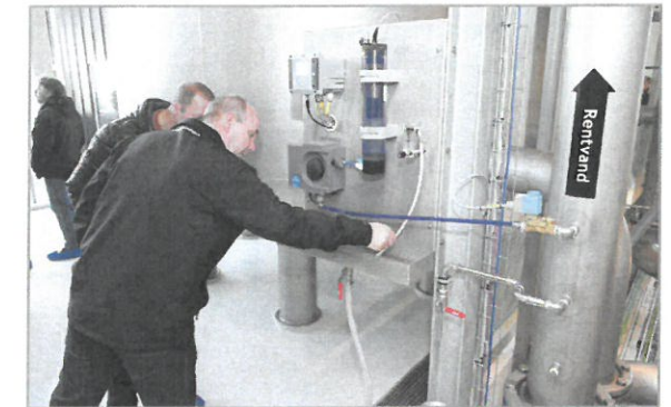
Opleve mekanikken/følge vandet.
